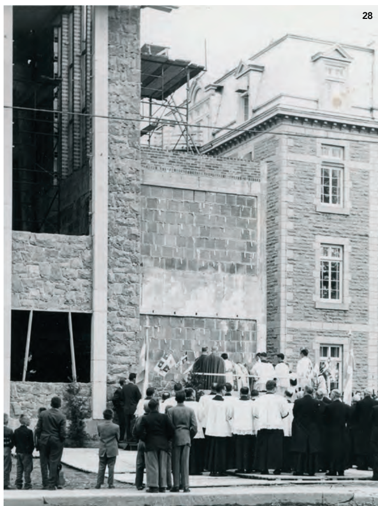
Des anciens réunis lors de la construction.
